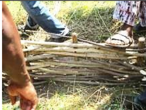
Réalisation d'une fascine
